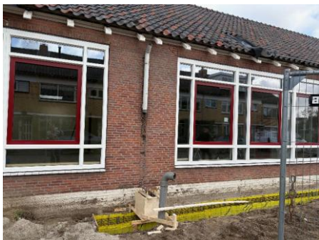
fundering voor de staalconstructie
